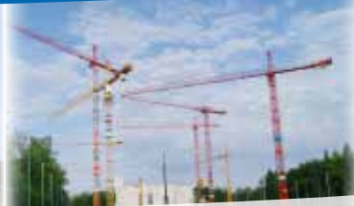
Monitorización en Zonas de Construcción
