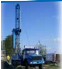
Ensayos de Bombeo
