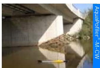
Aforo en pasarela con contrapeso Sinkers
